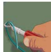
e. Corte o excesso do cordão de solda com o cabo exato e o auxílio de uma lâmina externa quadrada.
