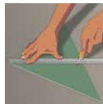
b. Corte uma peça triangular do tamanho da área a ser preenchida, utilizando o molde de ângulo triangular;
