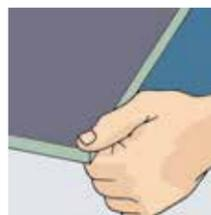
**24.1.** Inicie sempre em uma parede com o encaixe macho da régua voltado para ela;
