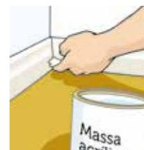
**e.** Faça os acabamentos das emendas com massa acrílica. Remova o excesso com um pano úmido e limpo.
