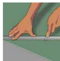
**16.2.** Com auxílio de um estilete corte a fita crepe exatamente na emenda das mantas;
