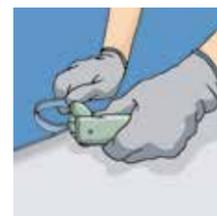
Devido ao processo de armazenamento vertical, as bordas das mantas sofrem naturalmente pequenos danos, como amassamentos ou impregnação de sujeira. Por isso, devem ser refiladas em pelo menos 1cm para melhorar a segurança da solda (fria ou quente). Este processo pode ser feito com um corta bordas ou com estilete, auxiliado por uma régua de metal.
