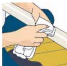
**b.** Limpe bem cada barra e parede onde o rodapé será instalado;
