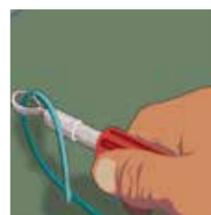
d. Corte o excesso do cordão de solda com o cabo exato e lâmina interna redonda.
