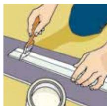
**c.** Aplique o adesivo de duplo contato sem toluol nas paredes e nas barras. Aguarde o adesivo secar por aproximadamente 15 minutos. Caso preferir, pode utilizar também fita VHB para essa fixação;
