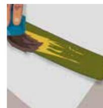
**20.3.** Aplique adesivo de duplo contato sem toluol nas paredes e no verso do rodapé (que deve estar limpo e livre de pó). Aguarde 15 minutos e cole o rodapé encostando a parte superior junto à linha e depois encaixe a parte de baixo;
