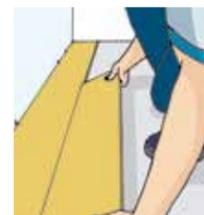
**24.4.** Para iniciar a segunda fileira, meça o ponto médio da primeira régua. Corte uma régua nesta medida e encaixe no comprimento da primeira régua. Para as próximas réguas, sempre inicie o encaixe pelo topo e depois encaixe o comprimento. Levante o conjunto para um melhor encaixe, caso necessário;
