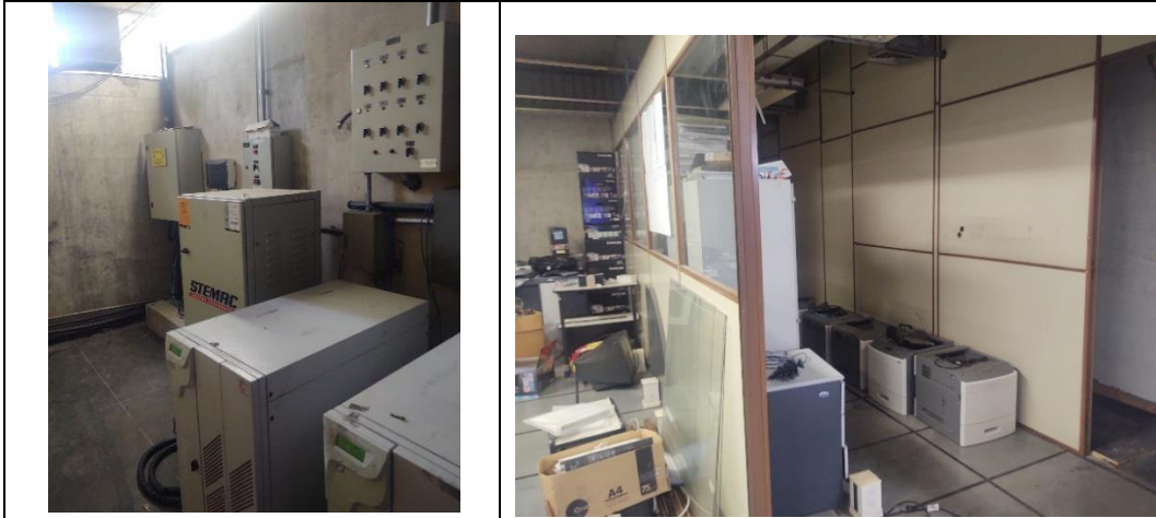
Retirada de equipamentos
