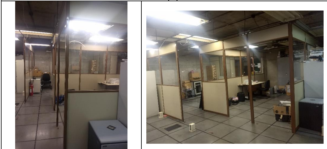
Retirada de divisórias, instalações elétricas e piso elevado
